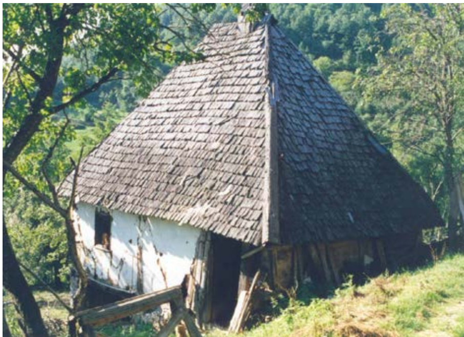
Слика 28. Чатмара покривена шиндром „на ћелици“ из села Годечево
