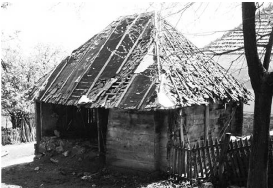
Слика 15. Полубрвнара-получатмара покривена шиндром из села Маковиште
