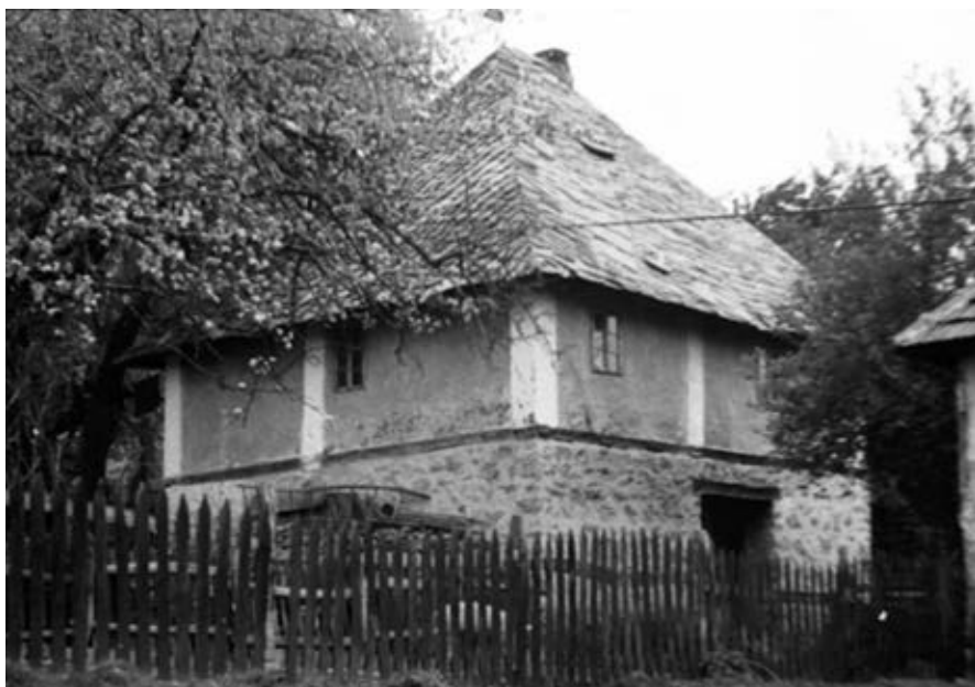
Слика 29. Чатмара покривена каменом плочом „на ћелици“ из села Годечево
