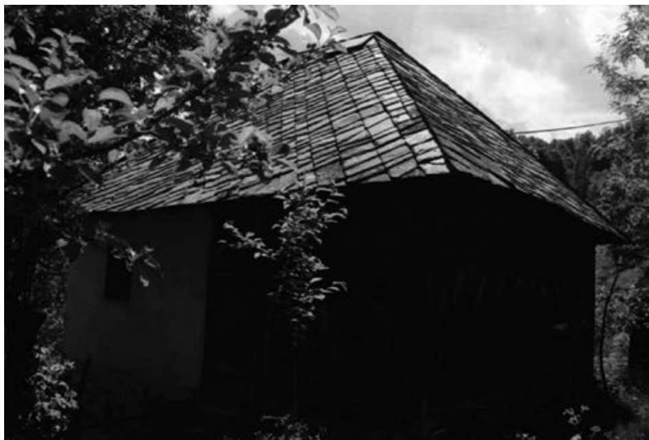
Слика 37. Полубрвнара-получатмара покривена каменом плочом из села Висока код Ариља
