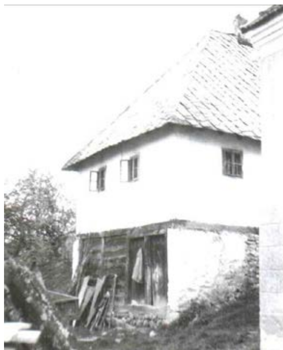
Слика 32. Чатмара покривена каменом плочом „на ћелици“ с искоришћеним таваном из села Годечево
