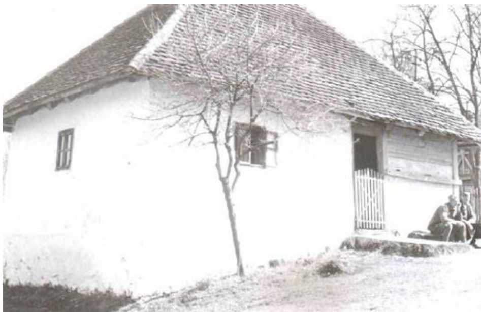
Слика 20. Полубрвнара-получатмара покривена бибер-црепом из села Радановци
