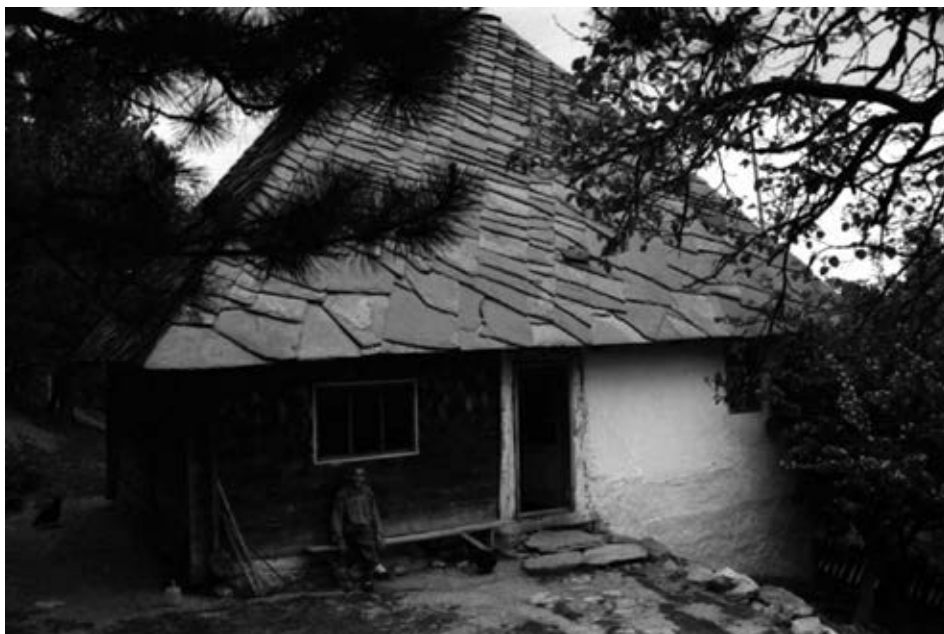
Слика 36. Полубрвнара-получатмара покривена каменом плочом из села Висока код Ариља
