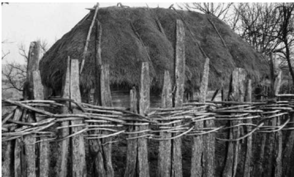
Слика 6. Једноделна талпара покривена сеном из села Брајковићи
