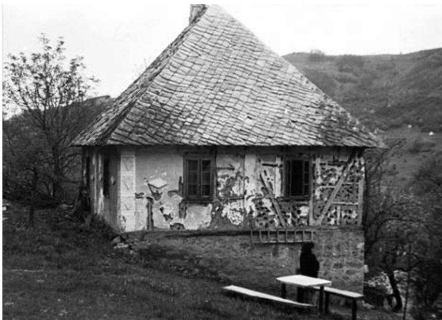
Слика 27. Чатмара покривена каменом плочом „на ћелици“ из села Годечево
