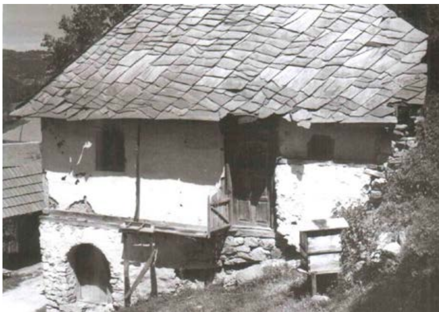
Слика 30. Чатмара покривена каменом плочом „на ћелици“ с искоришћеним таваном из села Годечево
