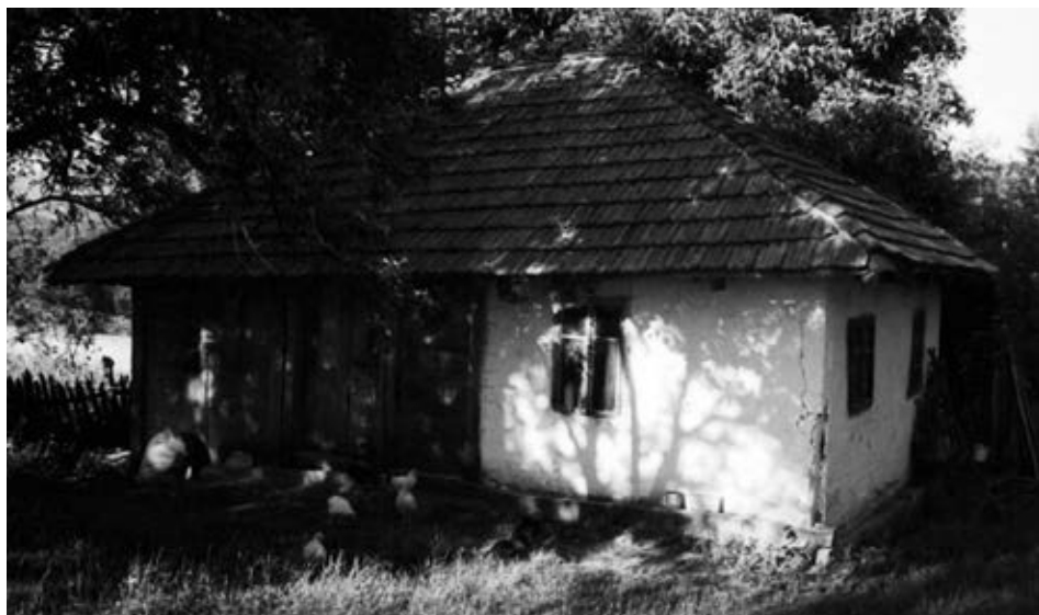
Слика 21. Полубрвнара-получатмара из села Брајковићи
