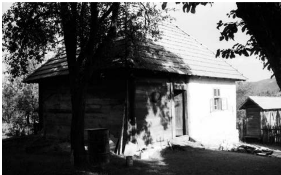
Слика 38. Полубрвнара-получатмара покривена каменом плочом из села Висока код Ариља
