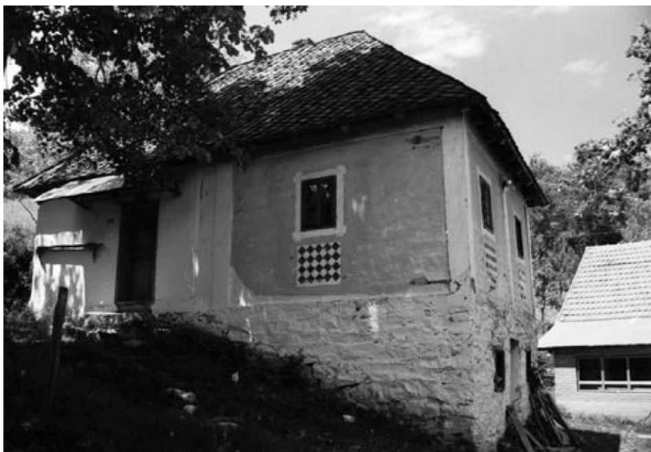
Слика 40. Чатмара покривена каменом плочом из села Висока код Ариља
