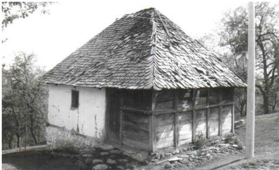
Слика 14. Полубрвнара-получатмара покривена шиндром „на копито“ из села Маковиште
