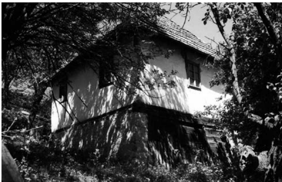
Слика 23. Чатмара покривена каменом плочом „на ћелици“ затвореној са чела брвнима из села Годечево
