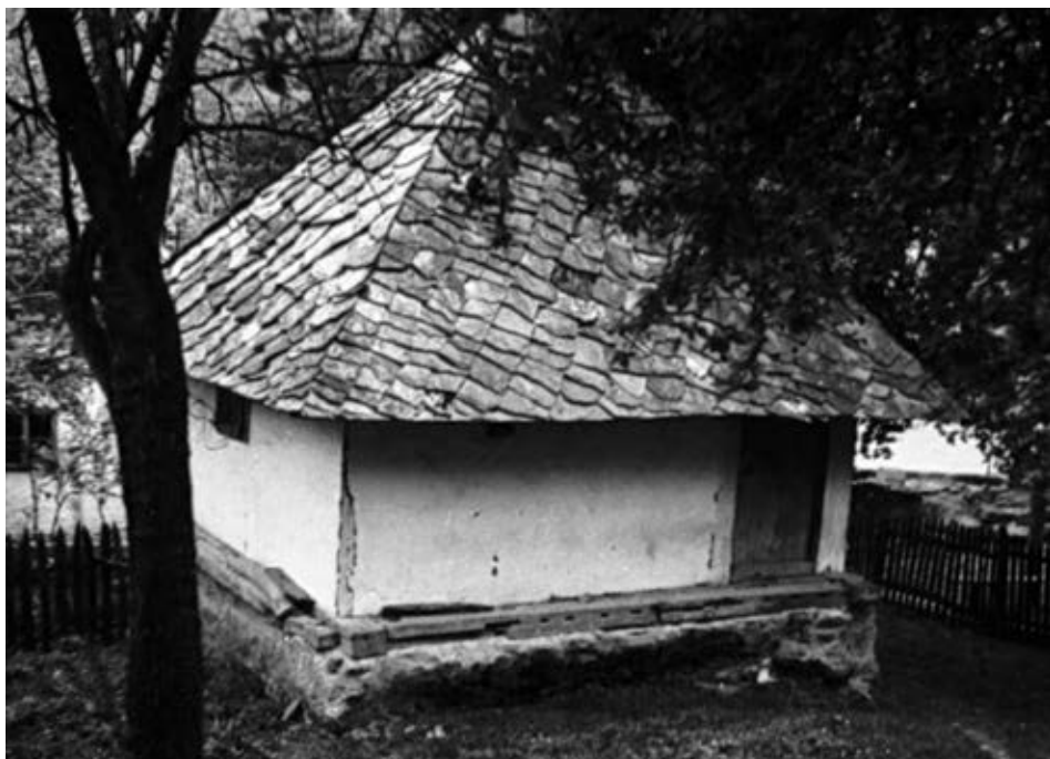
Слика 11. Једнопросторна кућа у бондруку покривена каменом плочом из села Годечево
