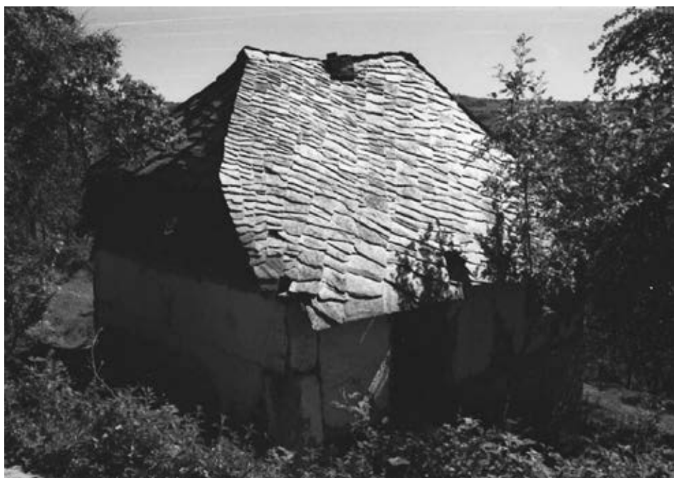
Слика 26. Чатмара покривена каменом плочом „на ћелици“ из села Годечево
