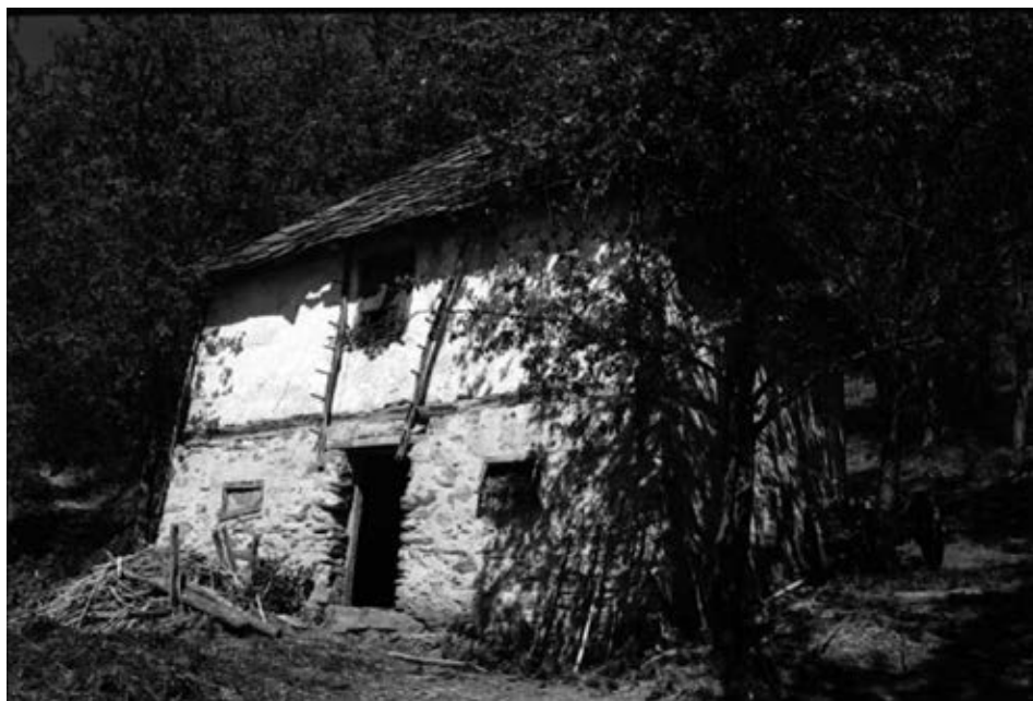
Слика 22. Чатмара покривена каменом плочом „на ћелици“ у целости зиданој из села Годечево
