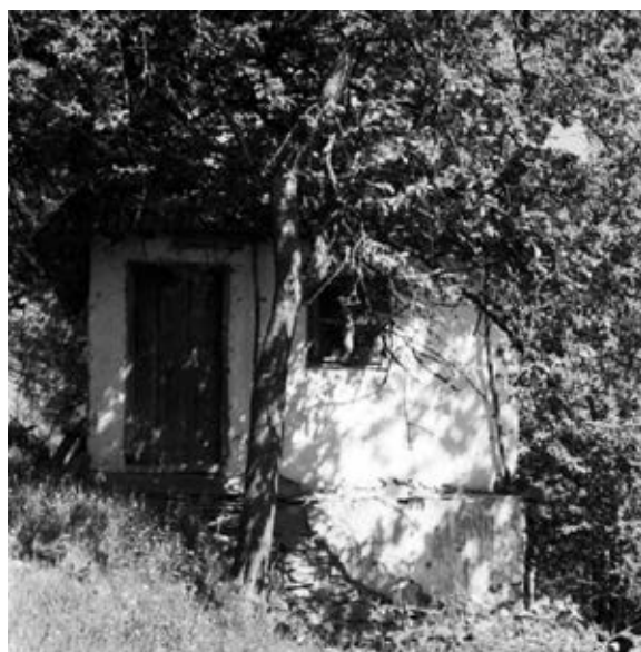
Слика 12. Једнопросторна кућа у бондруку покривена каменом плочом из села Годечево
