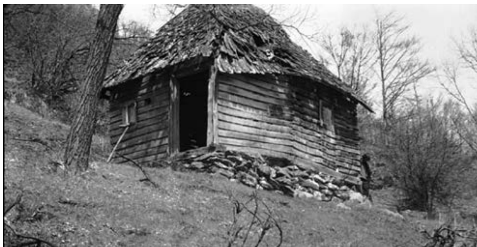
Слика 8. Колиба – једноделна кованица покривена шиндром с Малог Повлена
