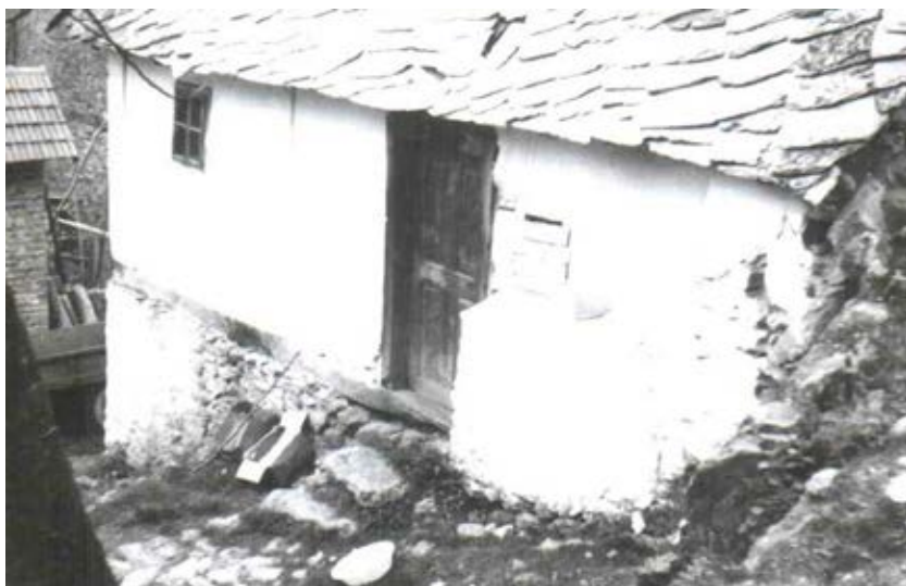
Слика 31. Чатмара покривена каменом плочом „на ћелици“ с искоришћеним таваном из села Годечево
