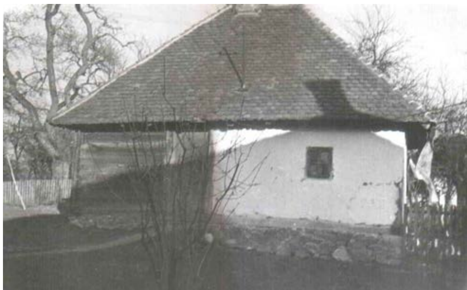
Слика 18. Полубрвнара-получатмара покривена бибер-црепом из села Парамун
