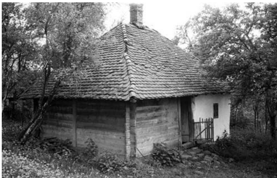
Слика 17. Полубрвнара-получатмара покривена бибер-црепом из села Мионица
