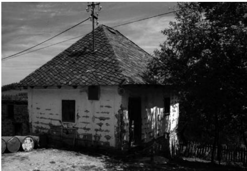
Слика 39. Чатмара покривена каменом плочом из села Висока код Ариља
