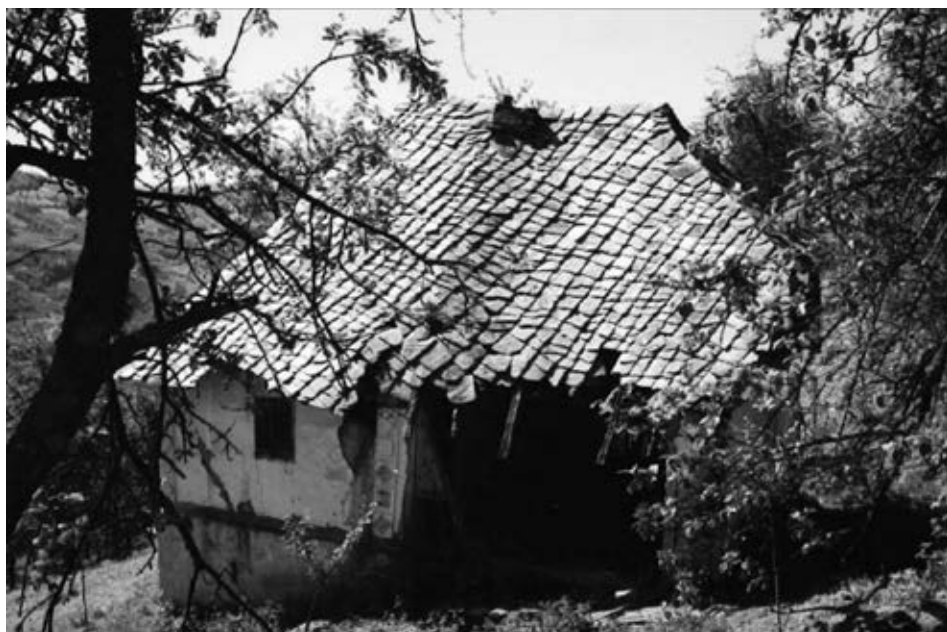
Слика 25. Чатмара покривена каменом плочом „на ћелици“ из села Годечево
