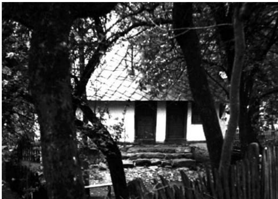
Слика 13. Двопросторна кућа у бондруку покривена каменом плочом из села Годечево
