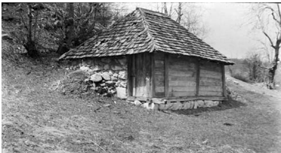
Слика 7. Једноделна полукамена-полуталпара кућа покривена шиндром с Павлина
