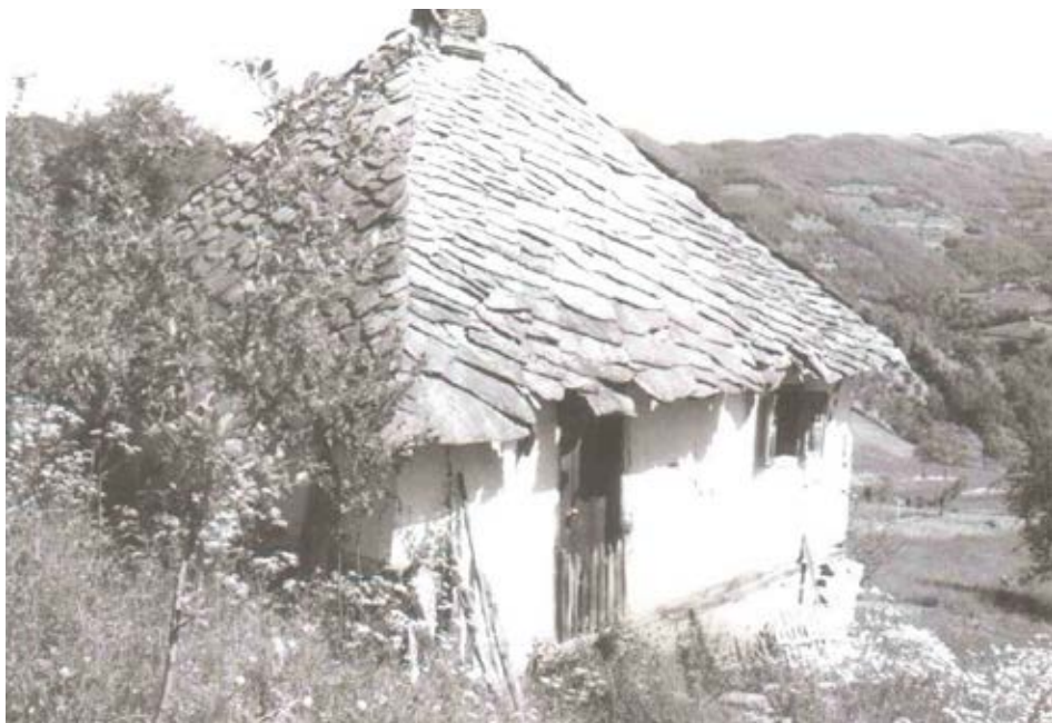
Слика 24. Чатмара покривена каменом плочом „на ћелици“ из села Годечево
