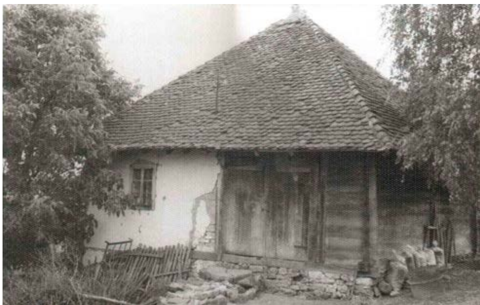
Слика 16. Полубрвнара-получатмара покривена бибер-црепом из села Мионица
